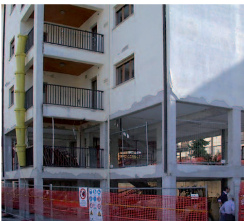
Figura 15 Condominio G4, via Belfi, località Coppito, prima dell'intervento di adeguamento sismico.
