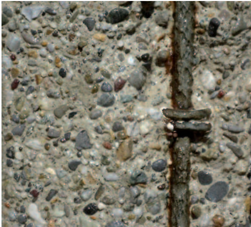
Figura 9 Fase 1 - Preparazione e saturazione del supporto in calcestruzzo.
